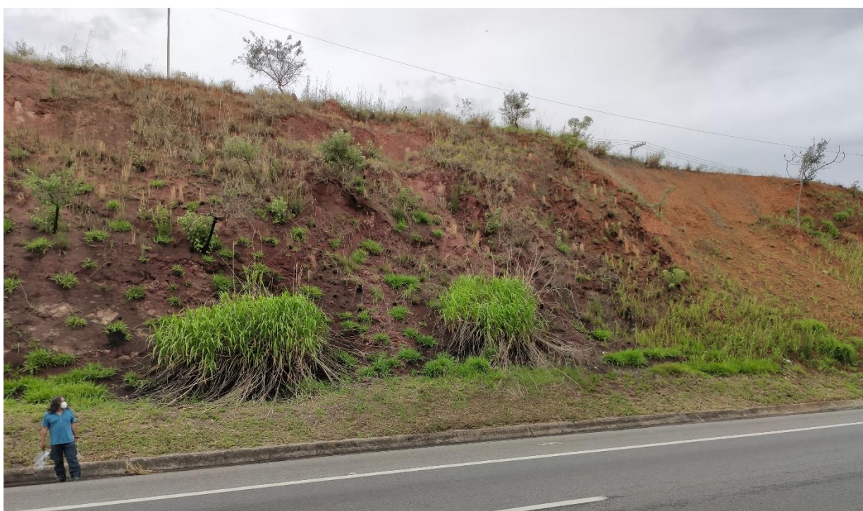
Imagem 1. Barranco como solo avermelhado na Rodovia Santos Dummont. À direita, porção avermelhada de solo argiloso e com erosão mais acentuada. À esquerda, solo arenoso, cinza a marrom escuro com porções de arenito aflorando.
